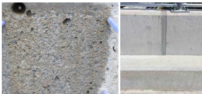
写真-3 打継ぎ目粗し面 写真-4 地覆・壁高欄近景
