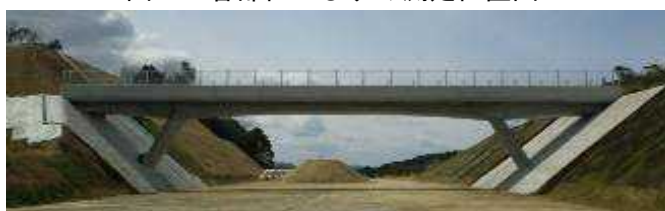
写真-5 折居跨道橋 完成写真
