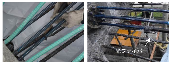
c) エポキシ被覆表層部切削
