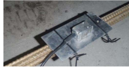
写真-3 加速度計配置状況
