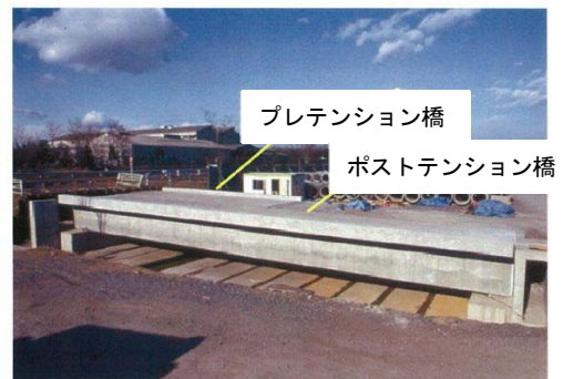
写真-1 建設当時のPC橋
