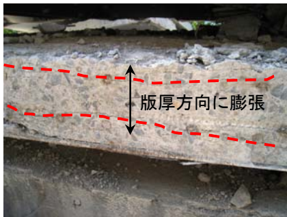
写真-3 床版および採取コアに生じた水平方向ひび割れ
