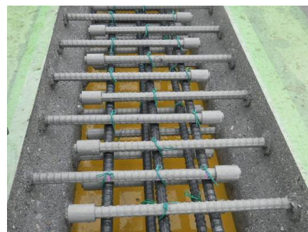
写真-1 エンドバンド継手
