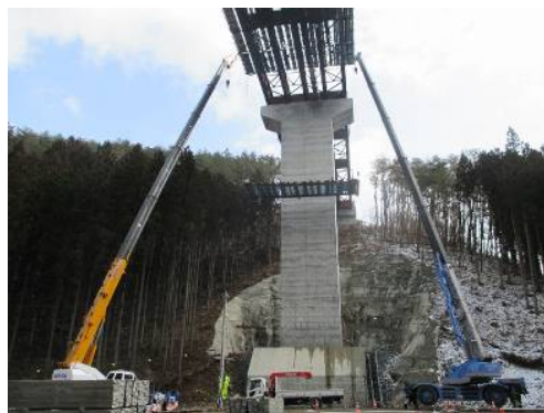
写真-5 吊足場組立状況
