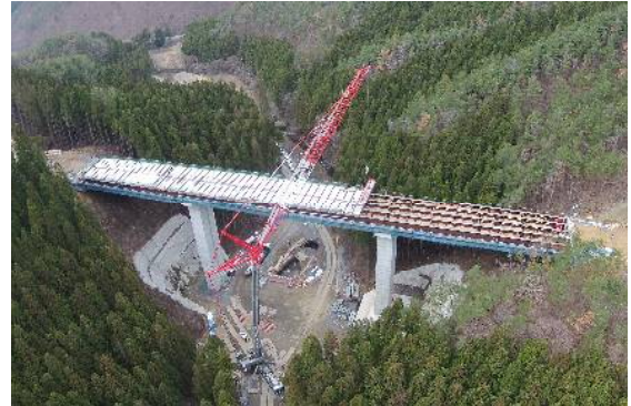
写真-1 プレキャスト床版架設状況
