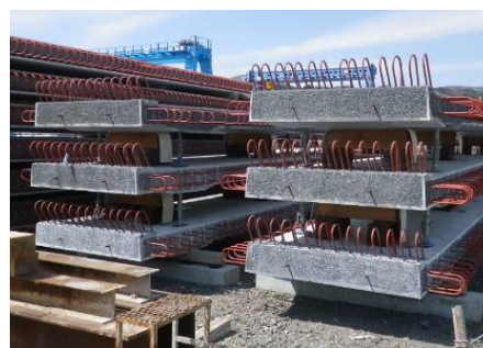
写真-2 床版打継部粗面仕上げ状況
