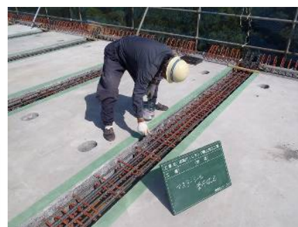
写真-3 吸水調整剤塗布状況
