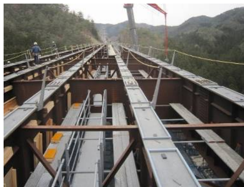
写真-4 ゴム支承, スポンジシール設置状況
