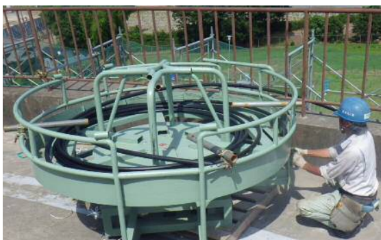
写真-4 PC鋼材養生状況
