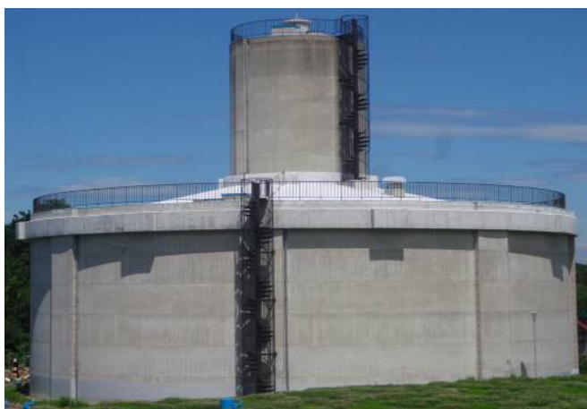
写真-6 完成写真(全景)
