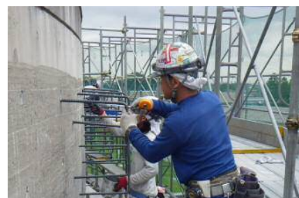
写真-3 アンカー鉄筋挿入状況
