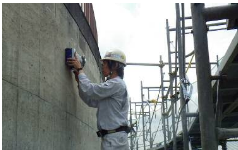
写真-2 鋼材探査状況
