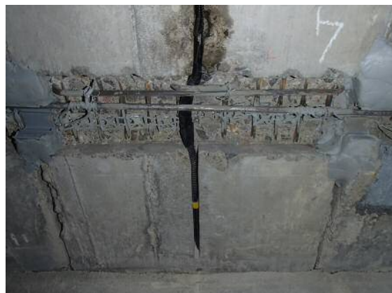
写真-6 PC鋼材導通処理
