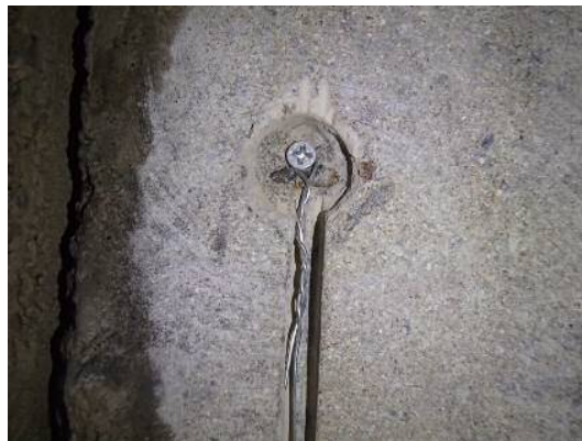
写真-5 かぶり不足部陽極設置状況
