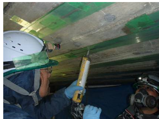
写真-4 陽極後埋め状況
