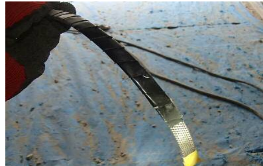
写真-3 かぶり不足部設置用陽極
