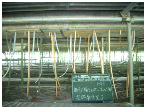
写真-7 モルタル注入状況
