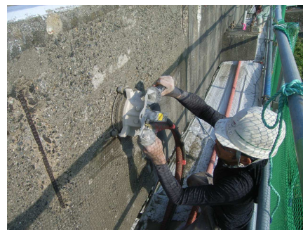
写真-2 表面処理状況
