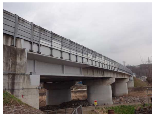
写真-8 補修後全景
