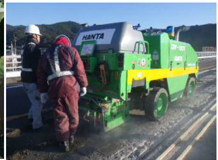
写真-9 切削状況
