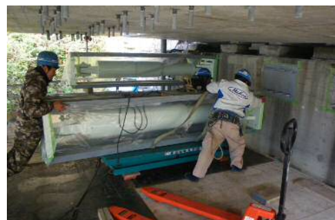
写真-2 制震ダンパー取付け (橋台側)
