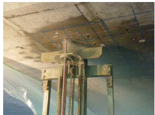
写真-7 ウォータージェット削孔状況
