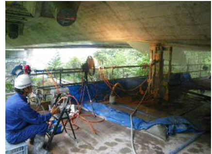
写真-9 WJ削孔時濁水処理
