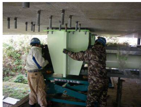
写真-3 制震ダンパー取付け (上部工側)
