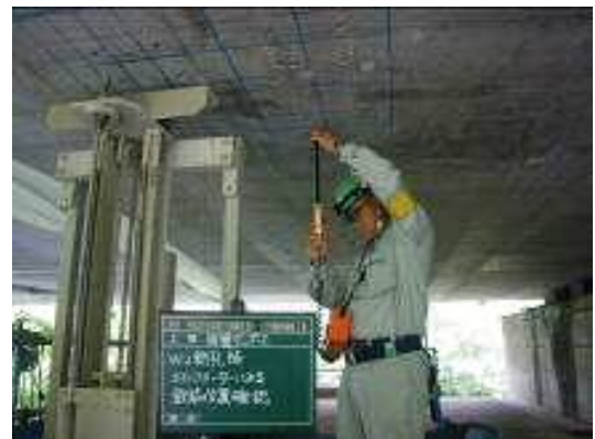
写真-6 鉄筋探査状況
