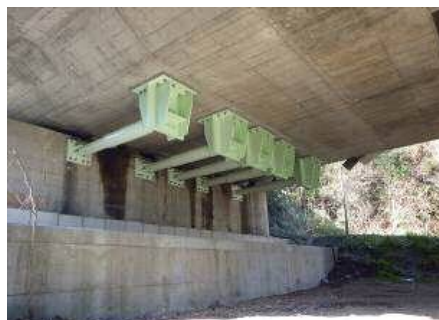
写真-12 制震ダンパー取付け完了
