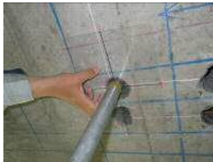
写真-10 パイプ挿入状況
