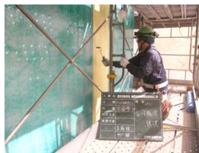
写真-7 シート貼付け
