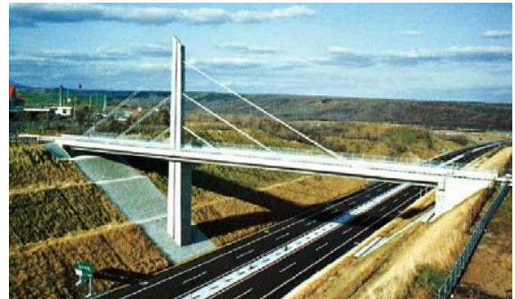
写真-1 建設時の写真
