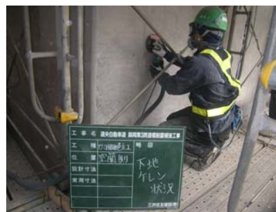
写真-6 下地処理
