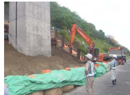
写真-3 掘削状況
