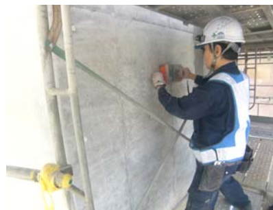
写真-5 段落し部鉄筋探査
