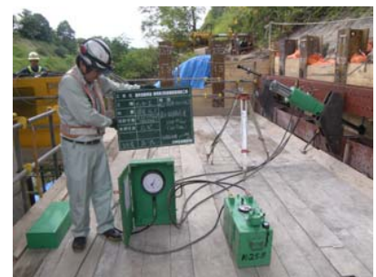
写真-4 アンカー試験
