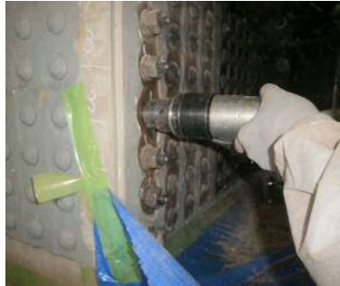
写真-4 ボルト取替状況
