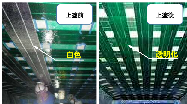
写真-6 炭素繊維への樹脂含浸状態
