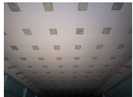
写真-3 炭素繊維貼付完了
