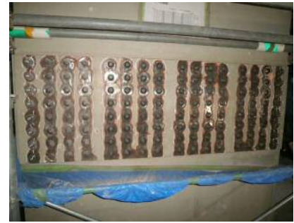
写真-5 ボルト取替状況
