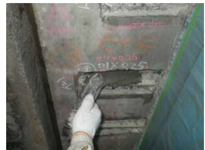
写真-2 断面修復状況
