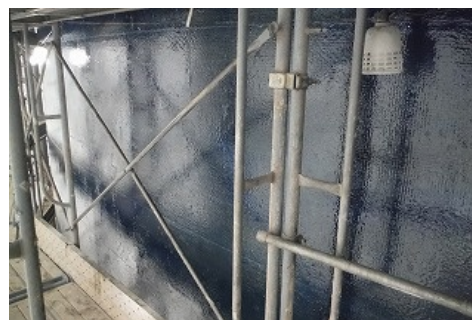
写真-13 貼付完了
