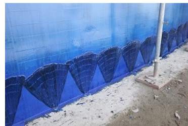
写真-12 貼付完了
