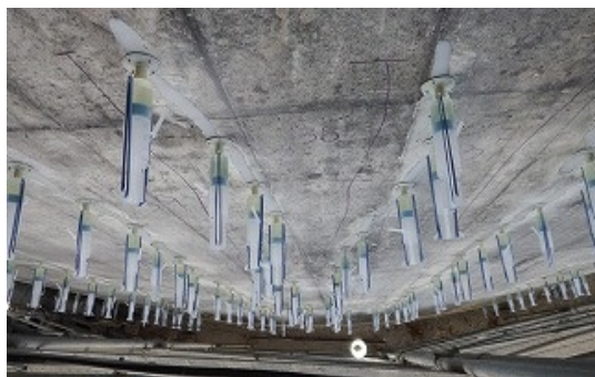
写真-3 注入工法
