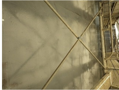
写真-6 エポキシパテ塗布
