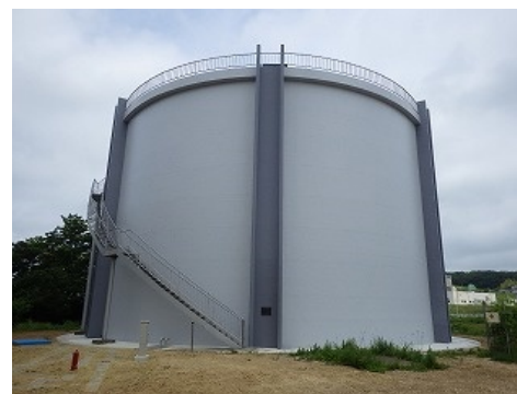
写真-14 炭素繊維補強完了
