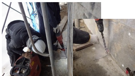
写真-10 削孔
