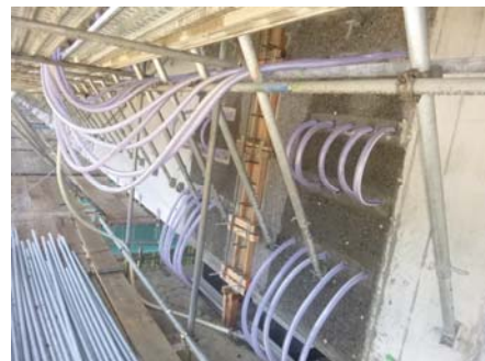
写真-5 クーリング実施状況
