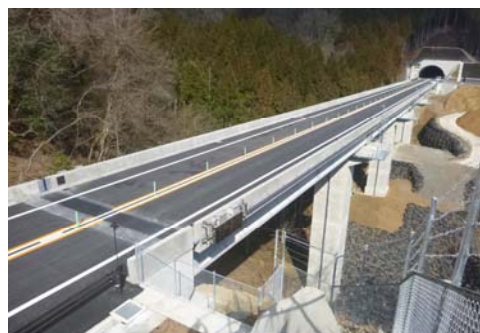
写真-6 橋梁全景
