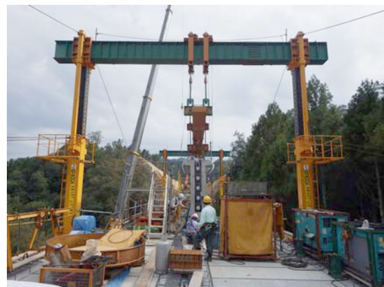
写真-2 主桁架設状況
