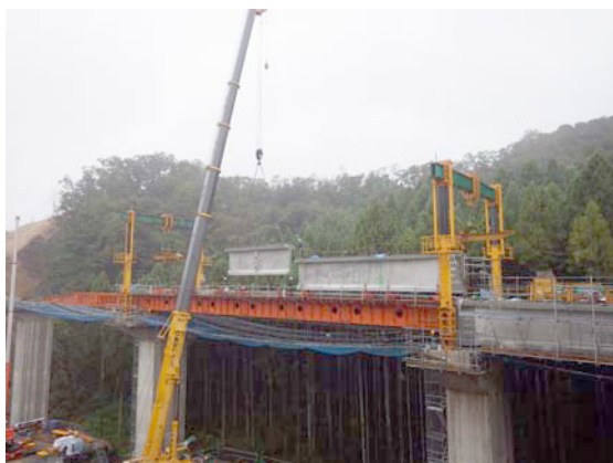
写真-1 セグメント取卸し状況
