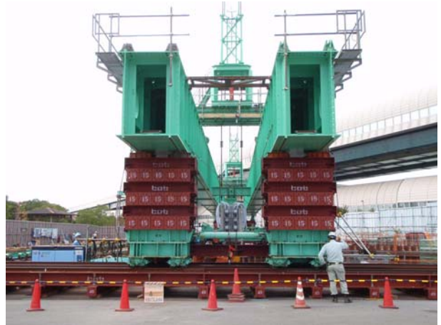
写真-2 主桁吊装置
