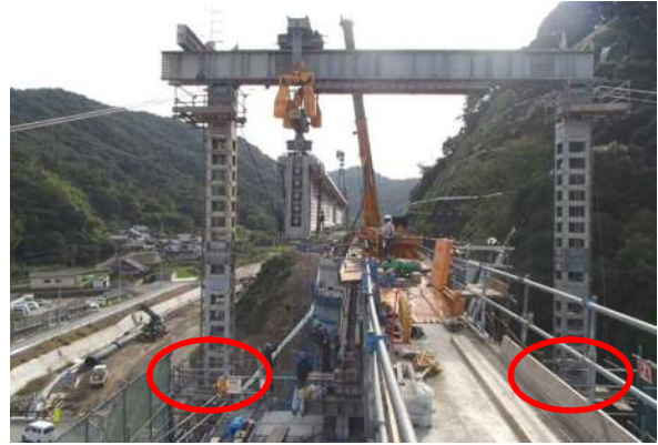
写真-2 水平器取付け箇所
