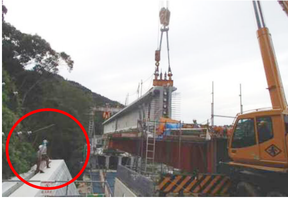
写真-1 下げ振りによる鉛直度確認状況
