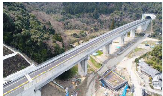
写真-4 完成写真
