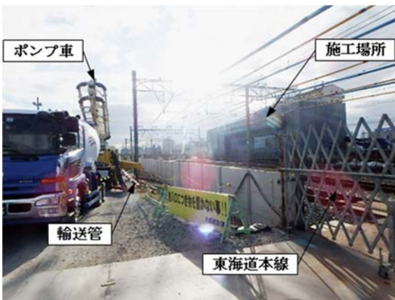
写真-5 ポンプ車配置状況
