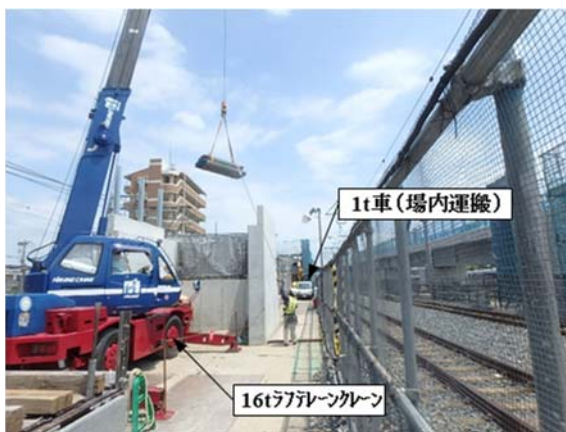
写真-2 資材搬入状況
