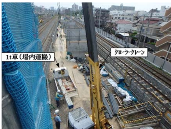
写真-3 資材運搬揚重状況
