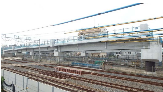
写真-6 完成写真
