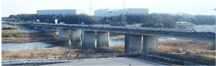
写真-1 荒川橋（工事着手前）
