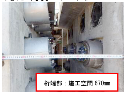
写真-5 定着具取付完了
