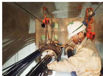
写真-6 緊張作業状況
