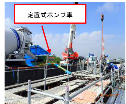
写真-2 コンクリート打設状況
