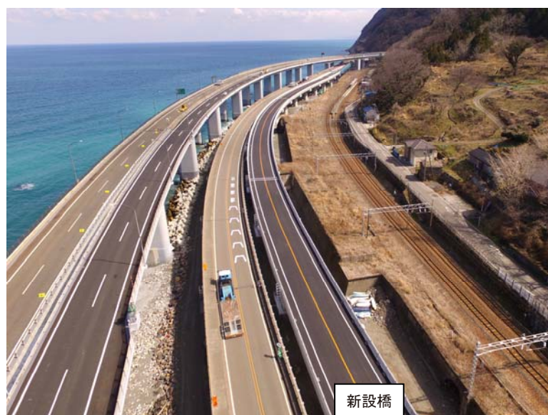
写真-7 完成写真
