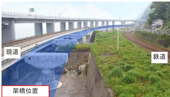
写真-1 現地状況
