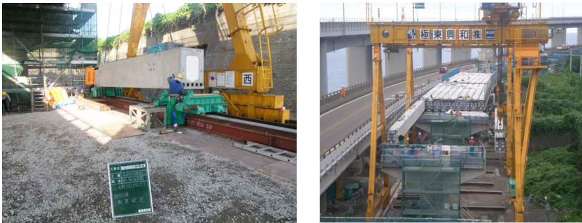
写真-3 ガントリークレーン架設状況
