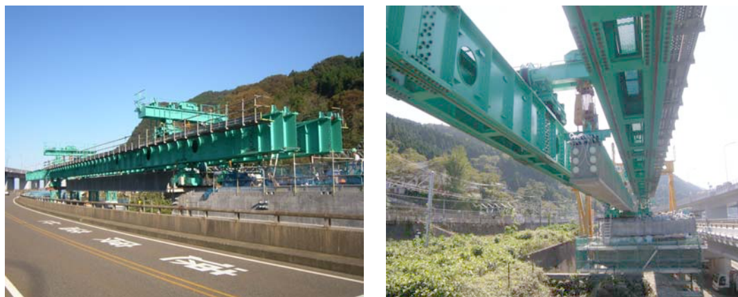
写真-2 抱き込み式二組桁架設状況
