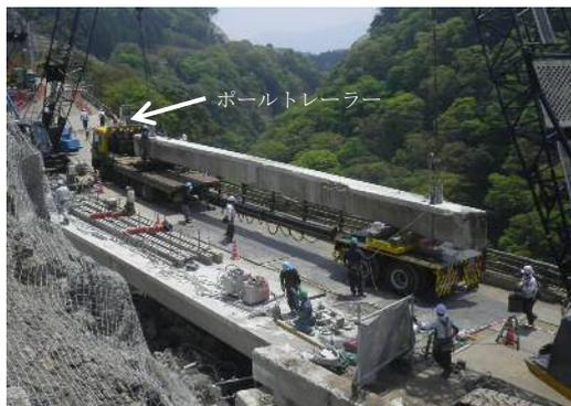
写真-4 既設桁撤去 (1期施工)
