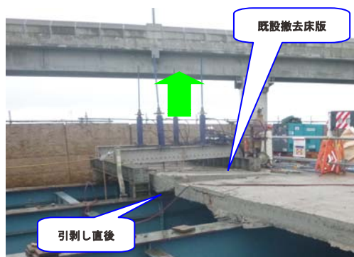
写真-6 床版撤去状況
