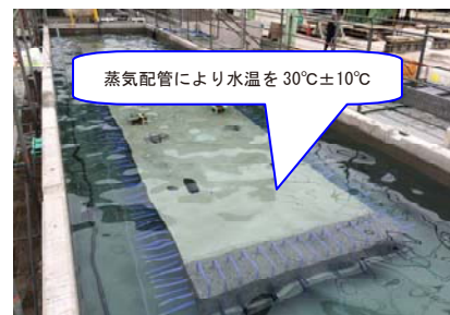
写真-3 PC床版の水中養生状況
