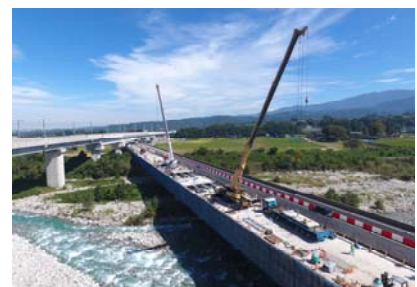
写真-1 工事区間全景
