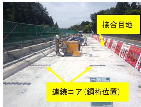
写真-4 カッター切断
