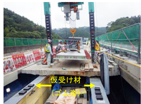
写真-5 プレキャストPC床版の架設
