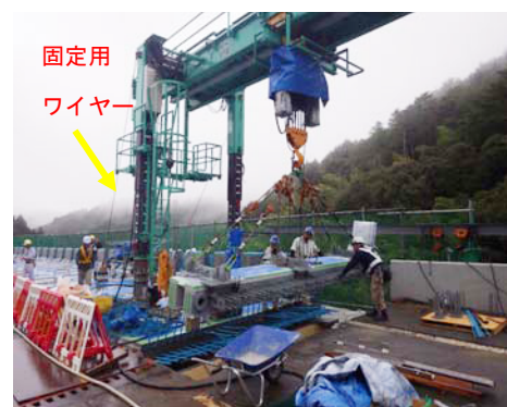
写真-8 伸縮装置の据付け
