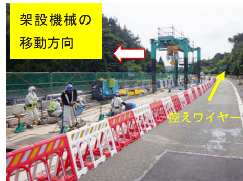
写真-7 架設機械の移動
