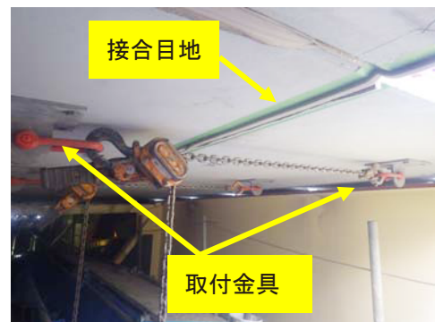
写真-6 引き寄せ状況
