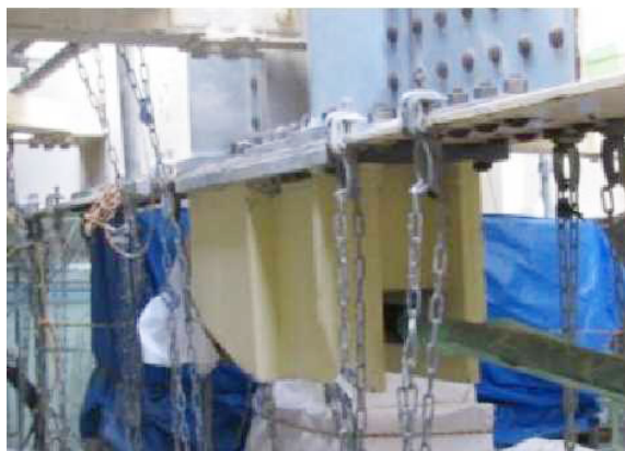
写真-1 外ケーブル定着部
