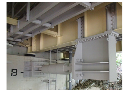
写真-5 支承およびダンパー設置完了
