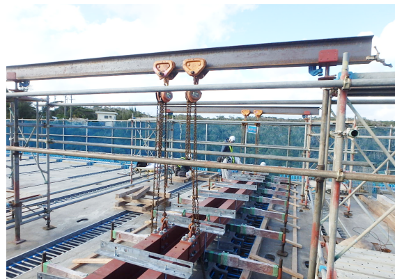
写真-1 伸縮装置設置用トローリー
