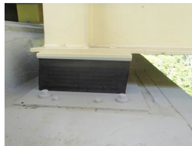
写真-5 支承およびダンパー設置完了
