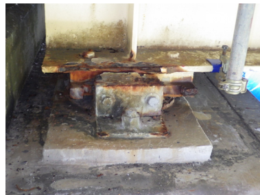
支承部 写真-3 支承および伸縮装置の劣化状況
