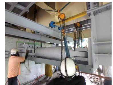
写真-4 支承およびダンパー設置状況
