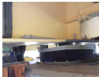
写真-4 支承およびダンパー設置状況
