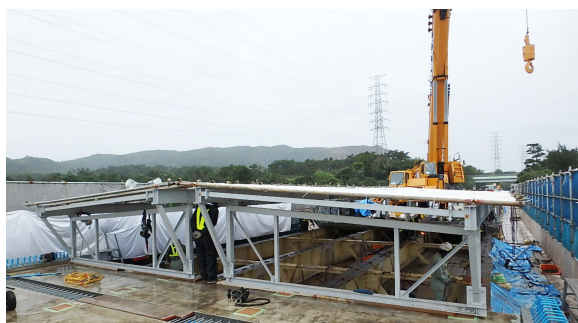
(本工事) 屋嘉および松田橋の仮設覆い
