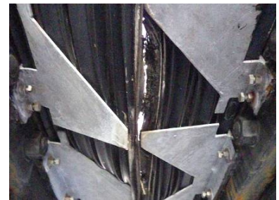
支承部 写真-3 支承および伸縮装置の劣化状況
