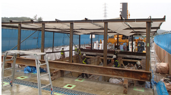
(過年度工事) 伊芸高架橋の仮設覆い
