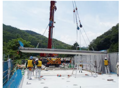
写真-2 延長床版施工状況
