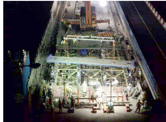
写真 - 5 PCa 床版夜間架設状況
