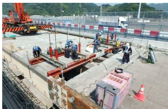
写真 - 4 既設床版の撤去状況
