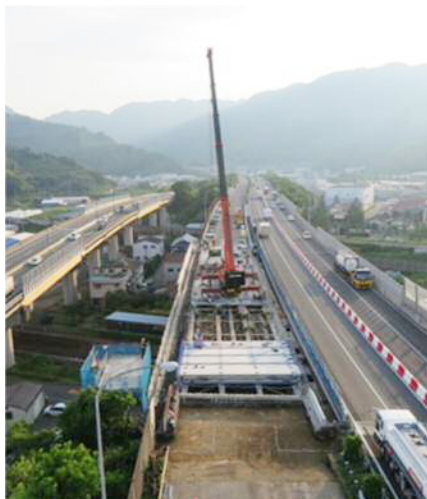
写真-1 施工状況
