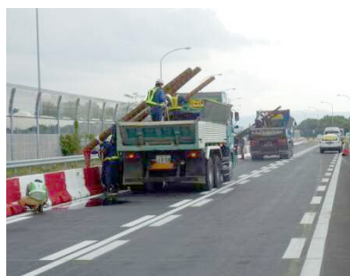
写真 - 8 仮設防護柵設置状況
