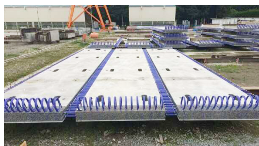
写真 - 3 PCa 床版仮組立状況
