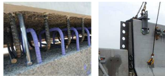
写真 - 6 PCa 壁高欄の架設状況
