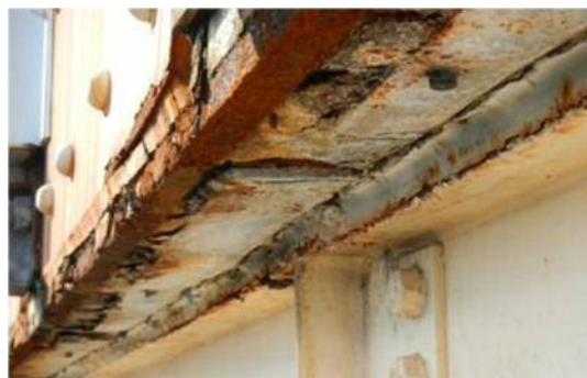
写真 - 2 壁高欄下面
