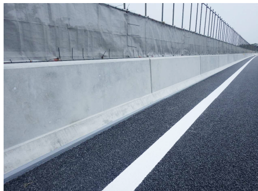
写真-5 PCa壁高欄完成
