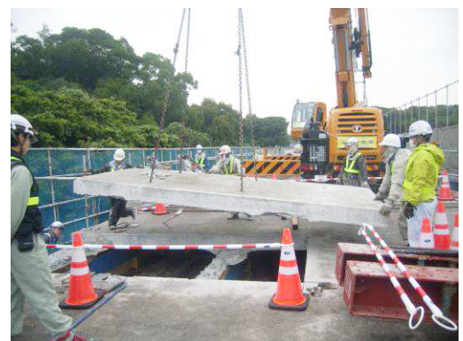
写真-1 試験施工状況
