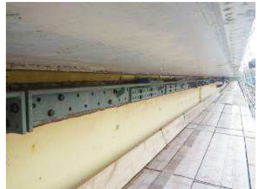
写真-2 補強部材 設置完了
