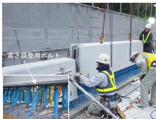
写真-3 PCa壁高欄架設状況
