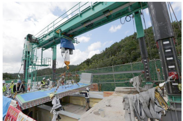
写真-1 PCaPC 床版架設状況
