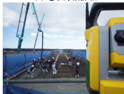
(6) 打設時床版高さ確認
