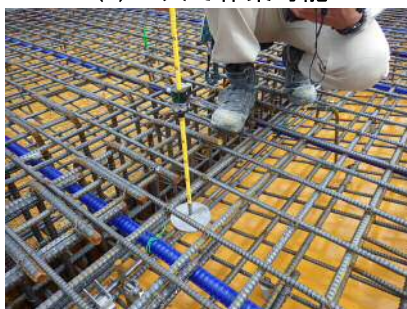
(5) PCケーブル高さ確認
