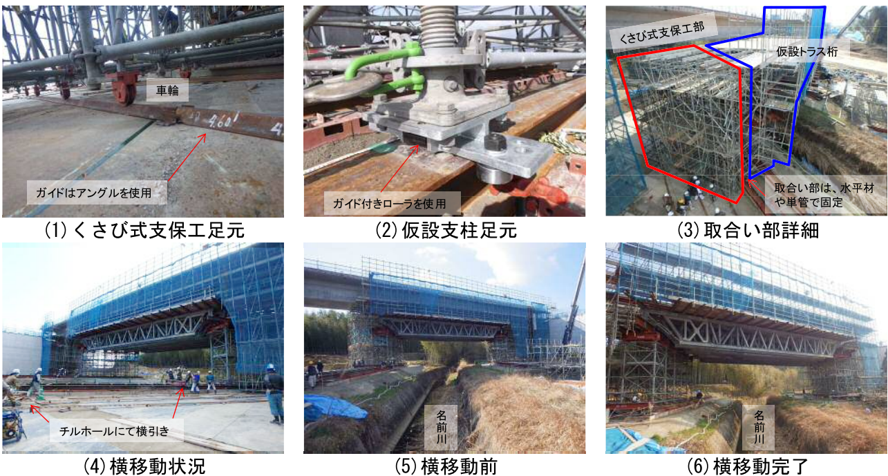
写真-1 仮設トラス桁・くさび式支保工同時横移動状況
