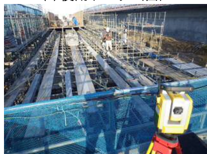
(4) 支保工ジャッキ高さ合わせ
