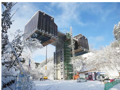
写真-1 移動作業車状況
