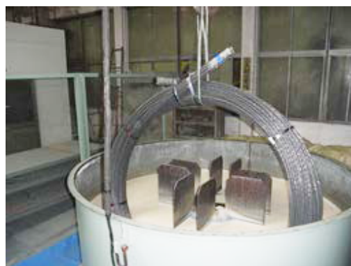
写真-3 PC鋼材一次防錆処理状況
