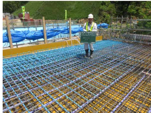
写真-9 桁端部配筋状況
