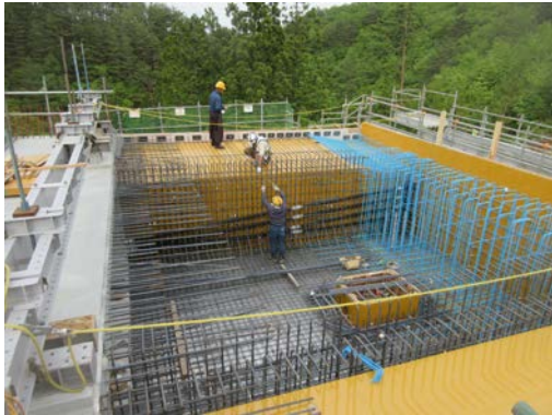
写真-8 桁端部配筋状況
