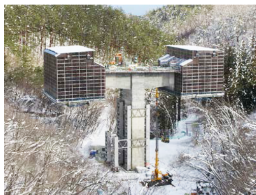
写真-2 移動作業車状況
