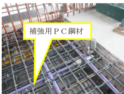
写真-11 補強用 PC 鋼材
