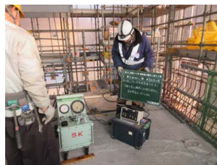
写真-12 緊張状況
