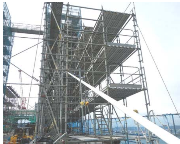
写真-5 斜材架設足場
