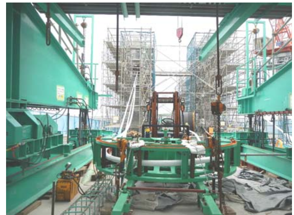
写真-6 ターンテーブル使用状況
