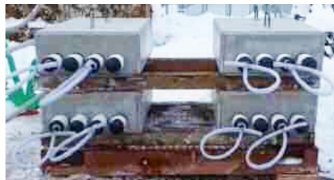
写真-3 供試体設置状況
