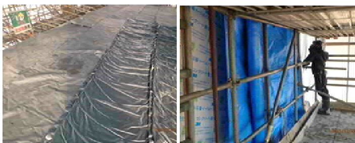
写真-2 養生状況（左：上床版，右：主桁側面）
