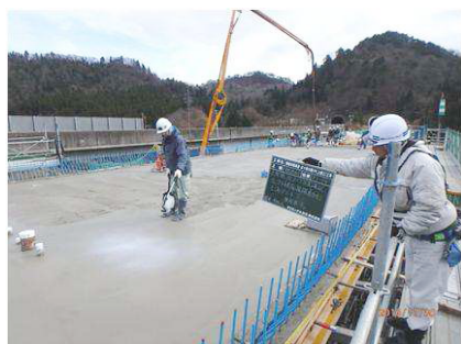
写真-7 表面養生剤散布
