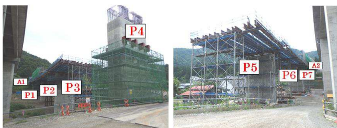
写真-1 支保工施工状況
