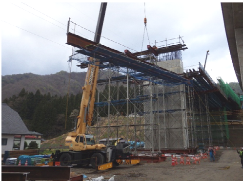
写真-4 梁材架設状況
