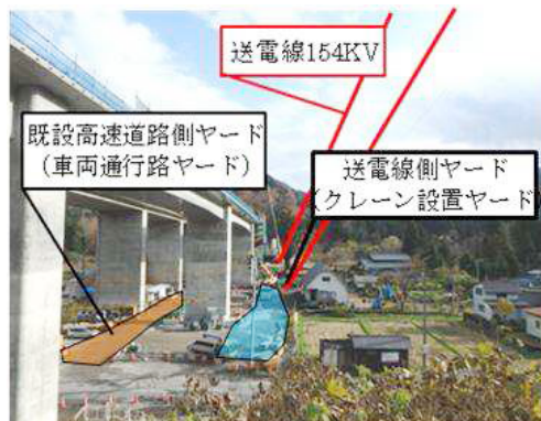
写真-3 送電線側ヤード
