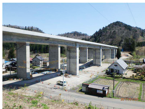
写真-9 全景 (平成 29 年 4 月)
