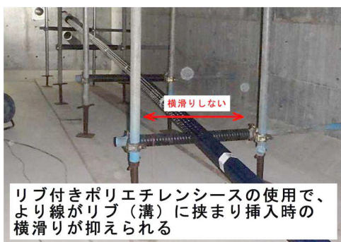
写真-6 外ケーブル挿入状況
