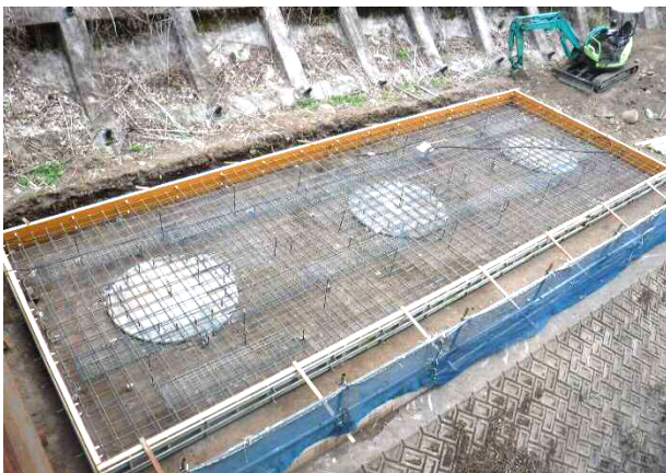
写真-1 仮設深礎施工状況
