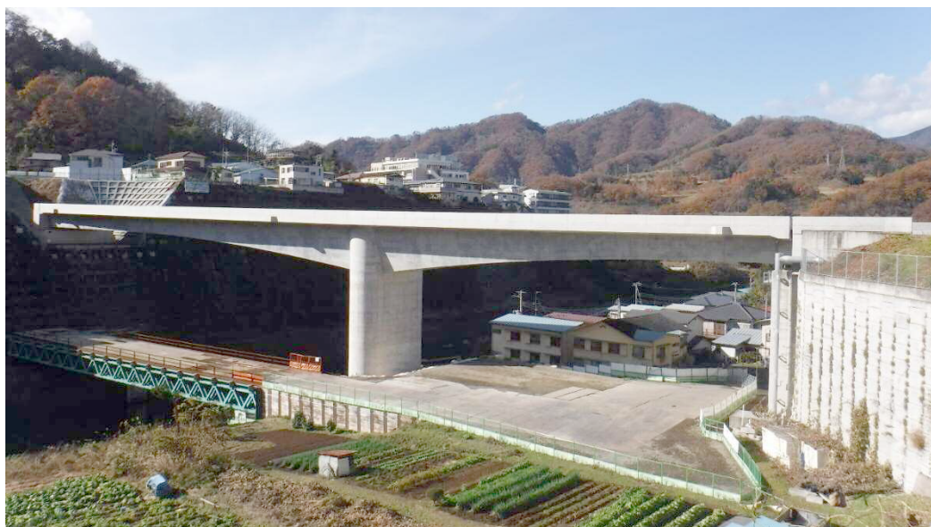
写真-2 大月バイパス 桂川橋遠景
