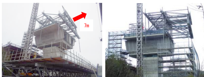
写真-1 移動作業車移動 移動前(組立て中) 移動後
