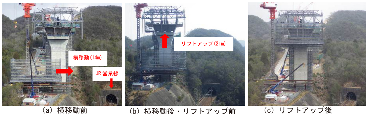
写真-2 下段作業台横移動・リフトアップ
