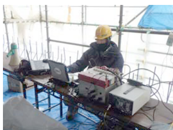
写真-5 注入管理システム による管理
