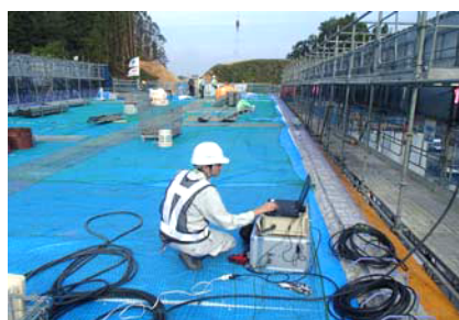
写真-3 緊張力測定状況
