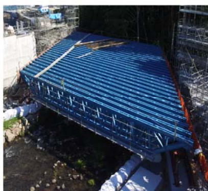
施工状況写真
