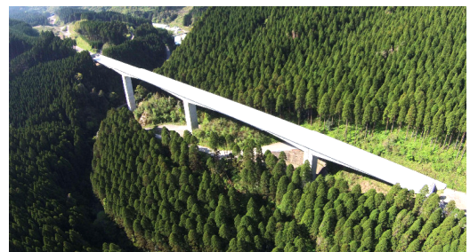
写真-3 完成写真
