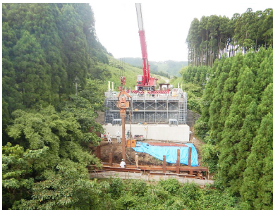
写真-1 杭打設状況
