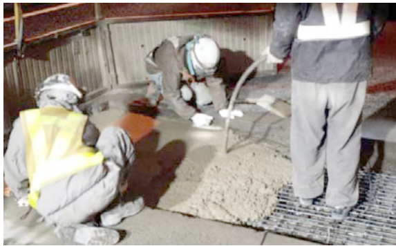
写真-1 ゲルバー部間詰め施工状況
