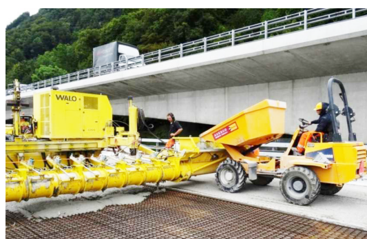
写真-1 海外での施工事例
