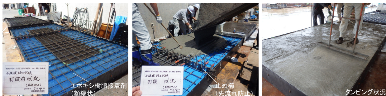
写真-3 施工状況(小規模施工実験)
