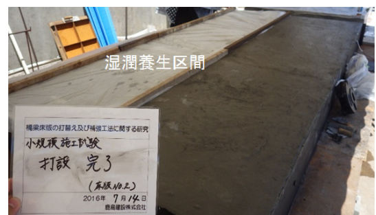
写真-2 初期養生の状況 (床版 No. 2)
