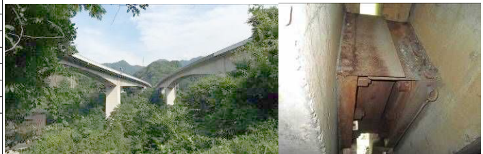
写真-1 全景および中央ヒンジ部ゲレンク沓
