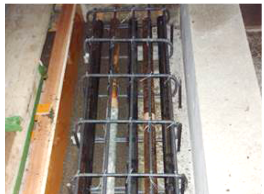
図-1-3 模擬地覆部砂敷込み・配筋状況
