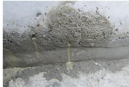
図-15 グラウト充填完了の状況
