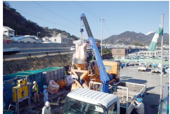
写真-5 混和材混入状況
