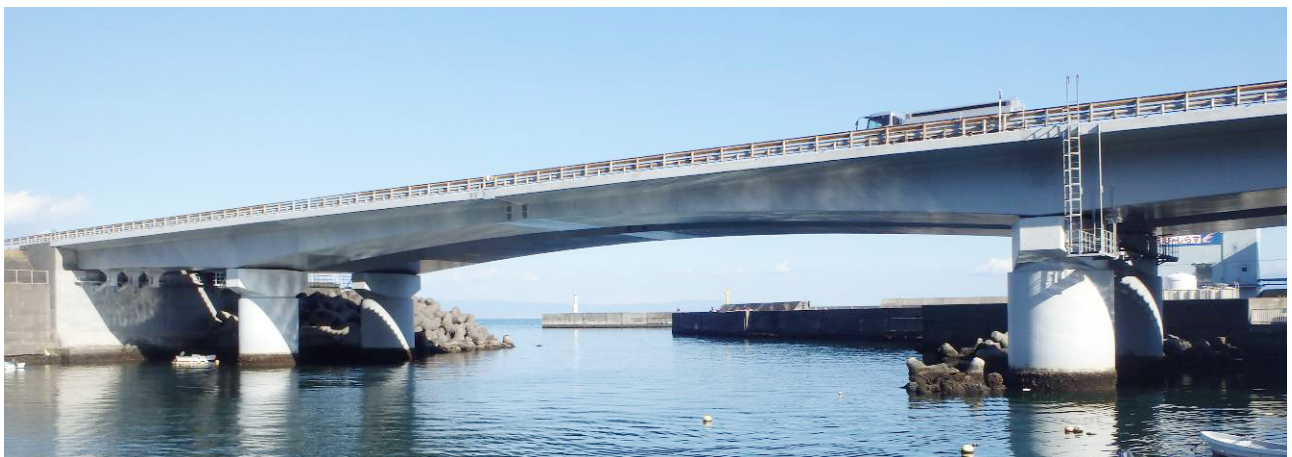
写真-7 完成写真
