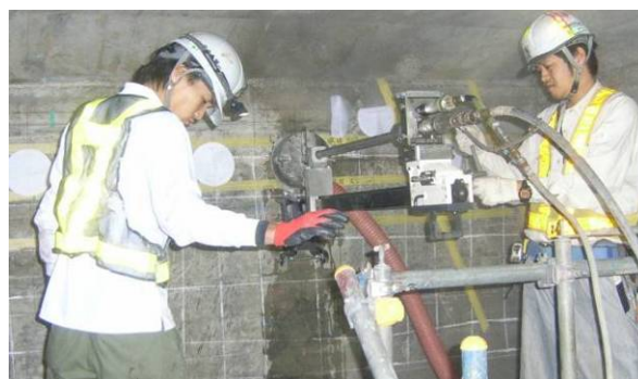
写真-3 ウォータージェットによる削孔状況
