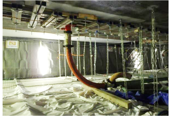
写真-4 下床版からの圧入状況
