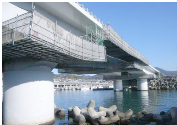
写真-1 吊足場の設置状況
