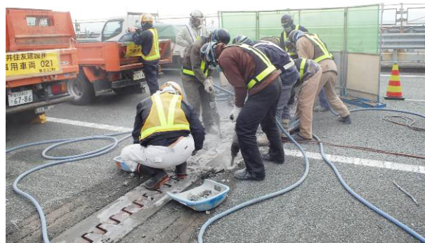
写真-2 伸縮装置の撤去状況
