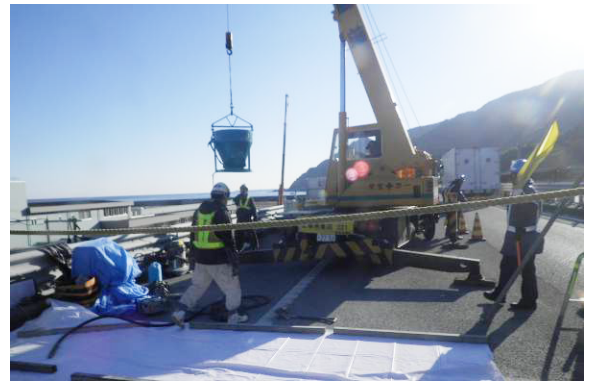
写真-6 コンクリート打設状況
