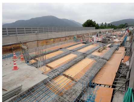
写真-6 床版撤去完了
