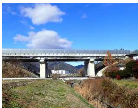
写真-7 完成写真
