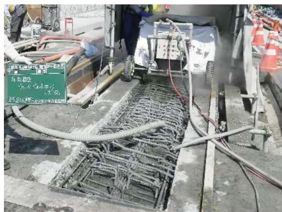
写真-3 主桁上部の床版のはつり状況
