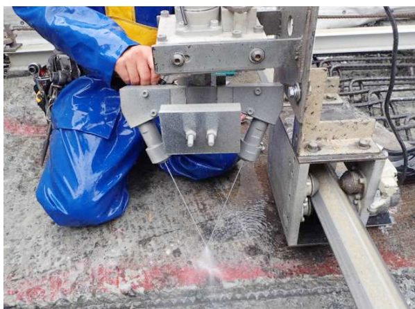
写真-2 コリジョンジェットノズル
