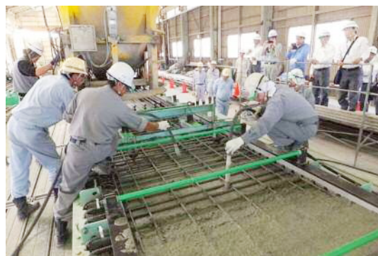
写真-2 実物大 PCaPC 床版供試体の打設状況
