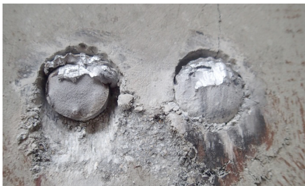
写真-7 スタッドの破断面(試験体No. 8)
