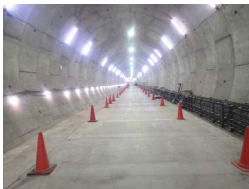
写真-5 床版架設完了
