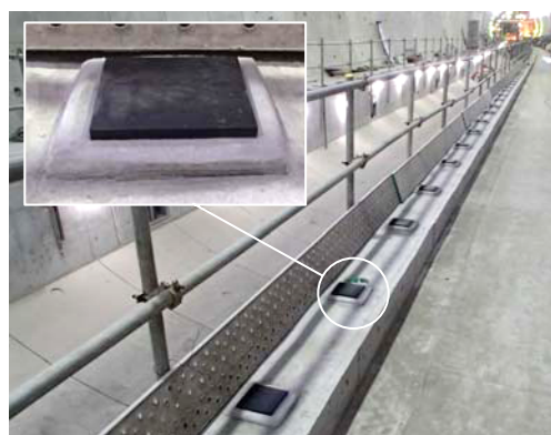
写真-1 仮沓設置状況
