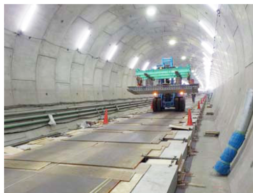
写真-2 シールド内運搬状況
