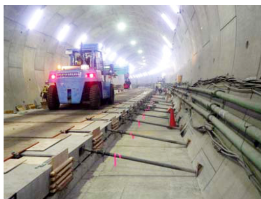
写真-4 直角方向のずれ止め
