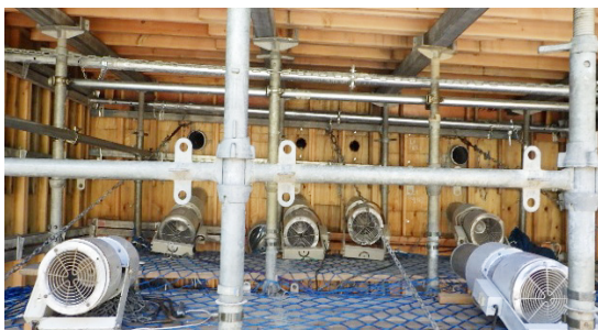
a) 偏向管への送風機設置状況
