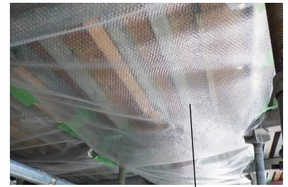
断熱材 (気泡緩衝材) 配置
