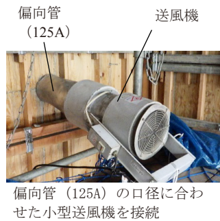
写真-1 温度差抑制対策実施状況
