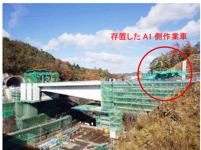
写真-3 A1側移動作業車存置状況
