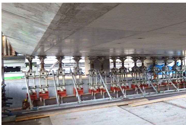
写真-4 仮支点設置状況
