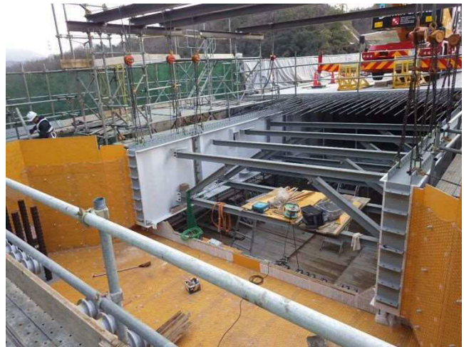
写真-1 A2側径間における波形先行架設 および型枠組立て状況
