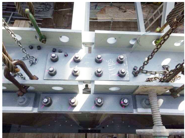
写真-2 波形鋼板ウェブフランジ接合状況
