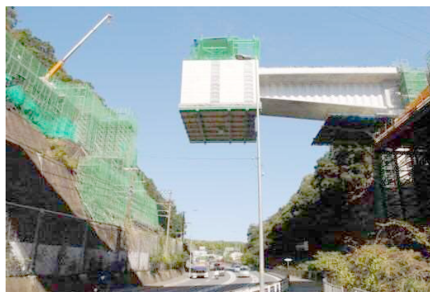
写真-5 国道上を通過する移動作業車
