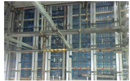
写真-3 ウェブ透明型枠
