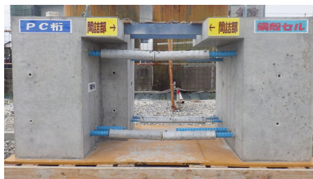
写真-5 試験施工
