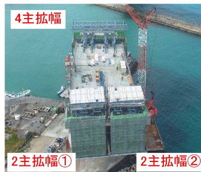
写真-2 移動作業台車(P5 張出)
