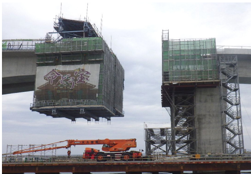
写真-4 側径間施工
