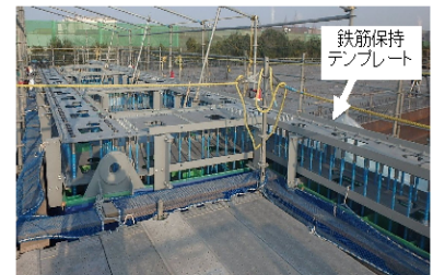
写真-6 鉄筋保持テンプレート
